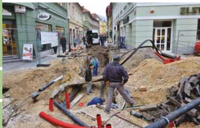
Del Krekovega trga in Prešernova ulica med obnovo (foto: arhiv MOC)
