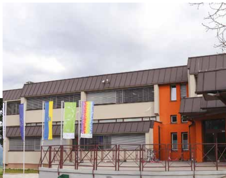
Energetska sanacija poteka tudi na II. osnovni šoli Celje. (foto: Gregor Katič)
