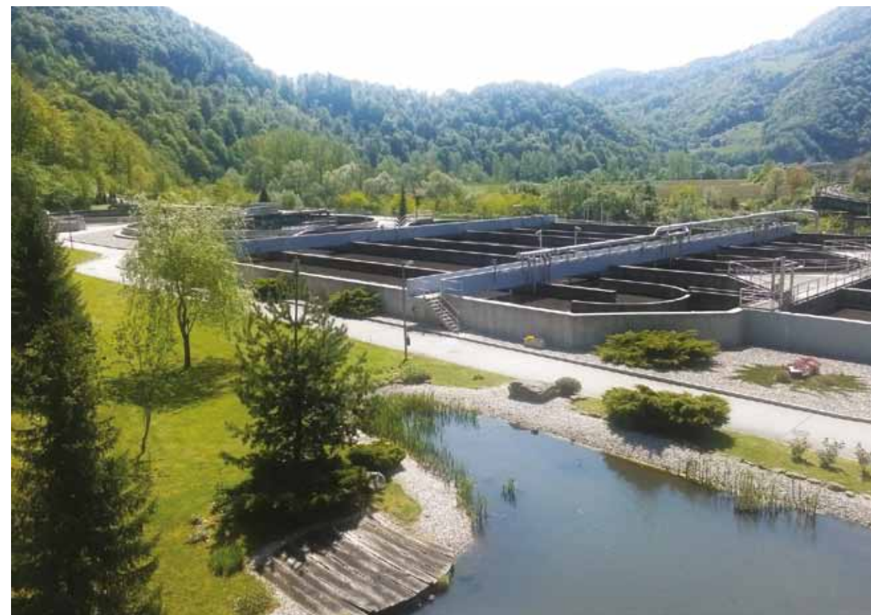
Čistilna naprava Celje (foto: arhiv VO-KA)
