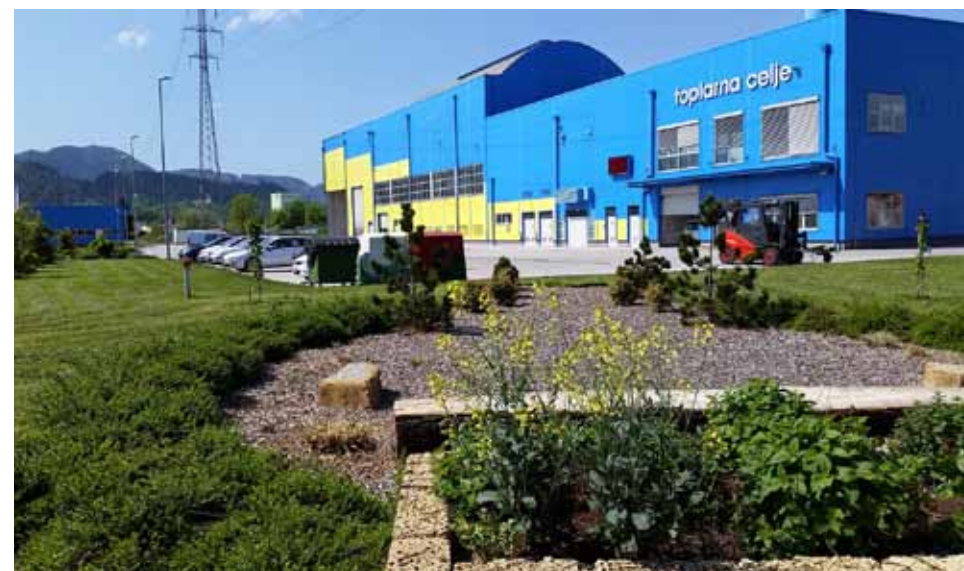
Toplarna Celje (foto: arhiv Energetike Celje)
