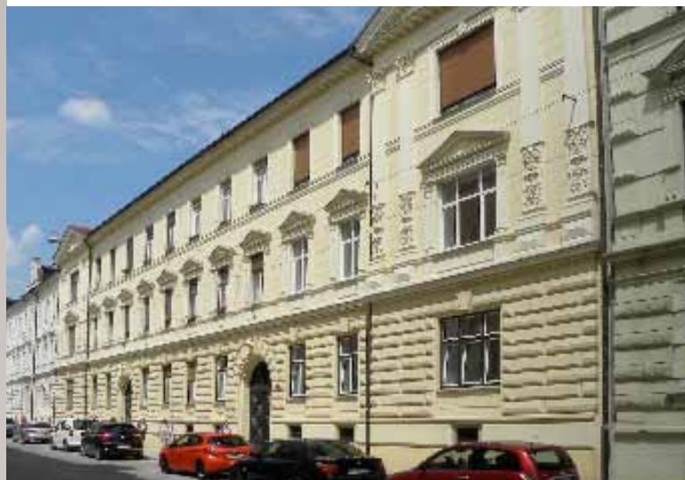
Stavba na Cankarjevi ulici po obnovi (foto: Marjana Krumpeštar)
