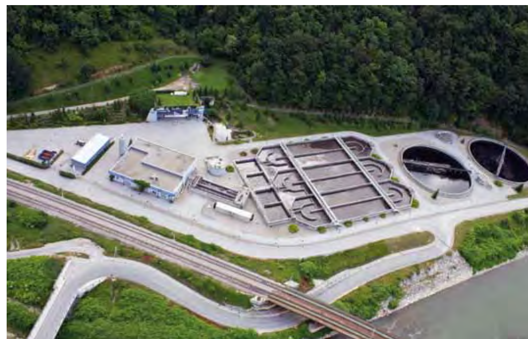
Čistilna naprava Celje
